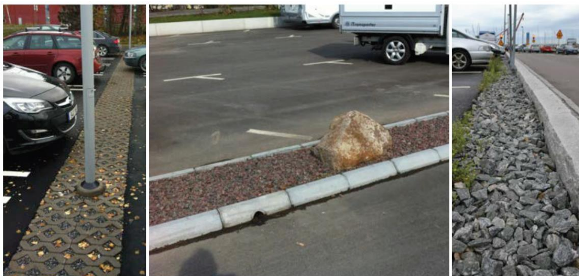
Tre exempel på utformning av makadamdiken. Till vänster en körbar yta med betonghålstén (med makadamdike under), i mitten inlopp till diket genom en kantsten med hål och till höger en ej körbar överyta.
